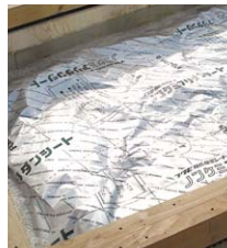
●ノンケミアリダンシート施工例
