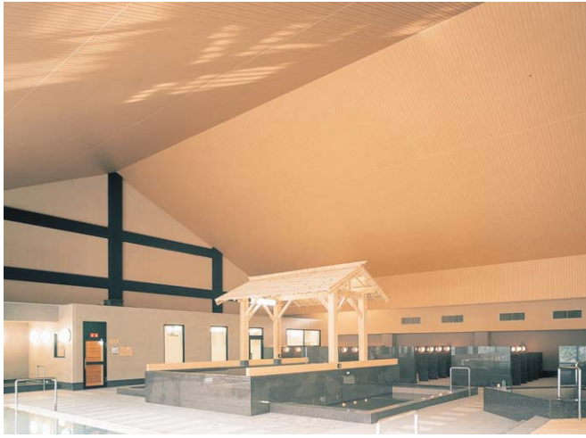
施工例 新生檜
