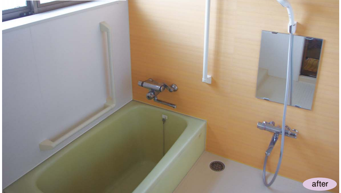
施工例 手すり左面 L型600、右面 I型 800 壁面 アルバレージ 左面 [NC]、右面 [TK] 床面 あんから [V]
