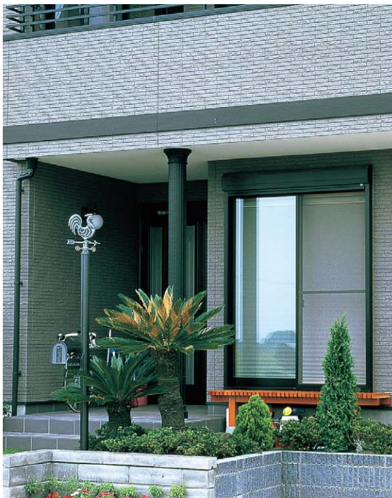
ポーチ柱エントラム
