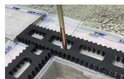
基礎天端部 土台ガード敷込み
