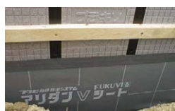
プラキソ立上り部 アリダンシート巻込み
