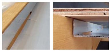
左右の折り目に3箇所ずつ入っているスリット位置で留める。 Uタイプが野地板下に遮気層を確保。
