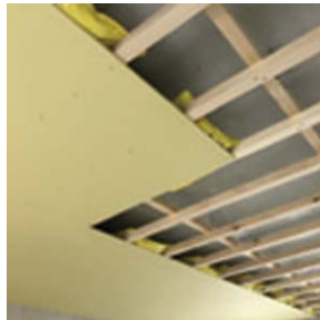
木製天井下地
