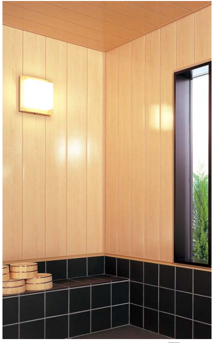
施工例：天井・壁 J1]やまと檜j
