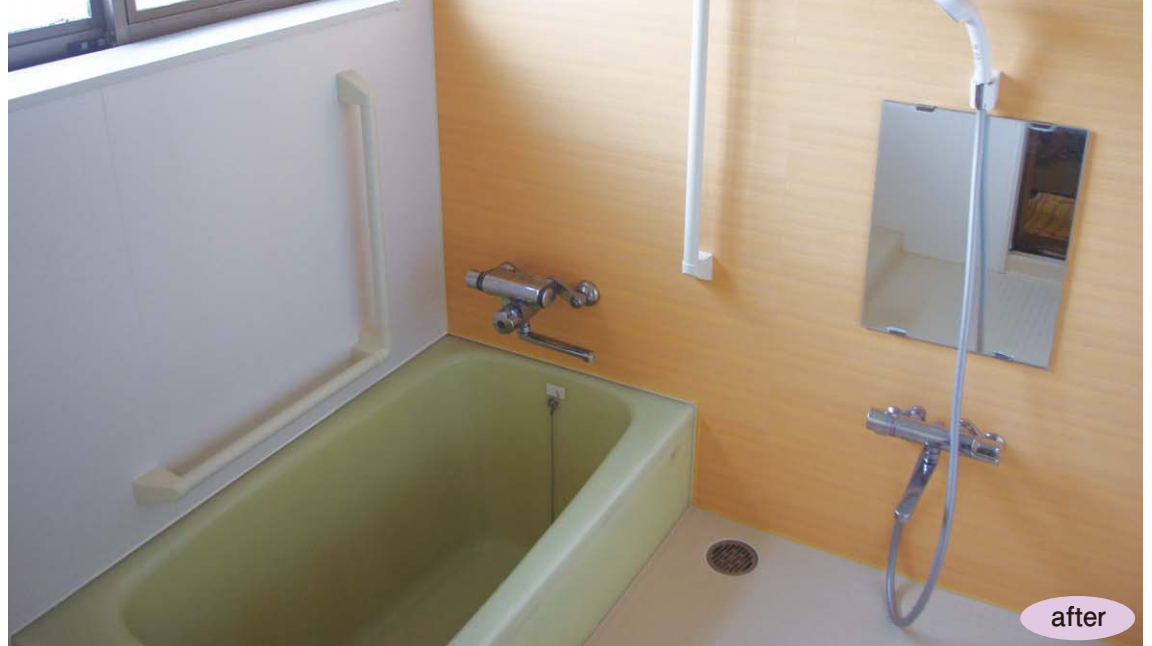
施工例 手すり左面 L型600、右面 I型 800 壁面 アルバレージ 左面 [NC]、右面 [TK] 床面 あんから [V]
