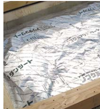
●ノンケミアリダンシート施工例
